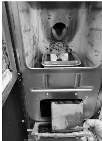
Fig. 67 - Remover o tampão de inspeção
